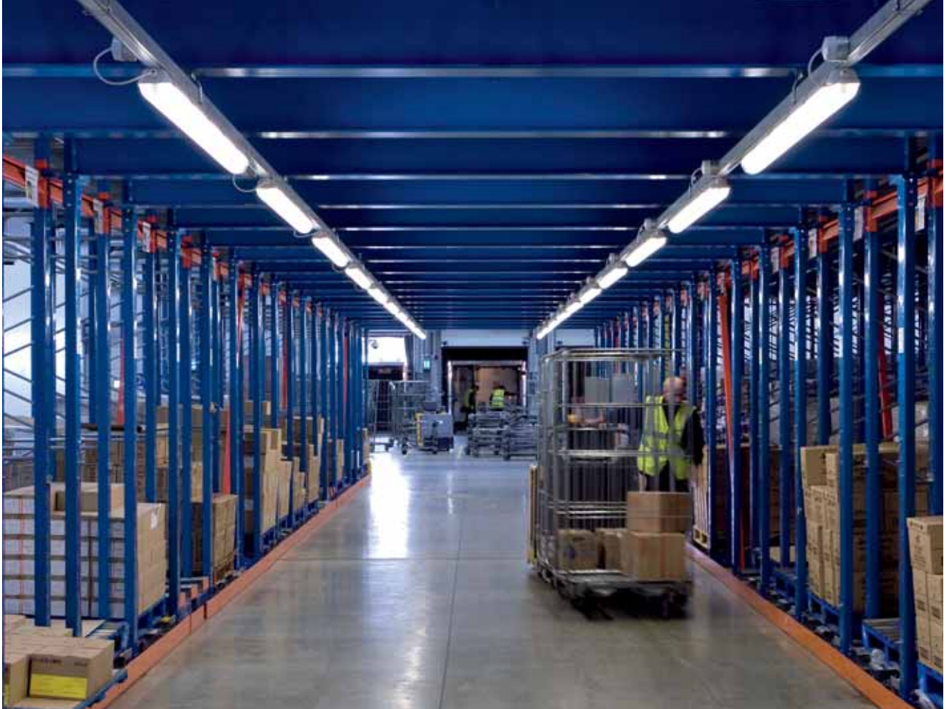
ImpactForce montuje się w magazynach, gdyż oprawy te są solidnie skonstruowane i odporne na uderzenia oraz drgania.
